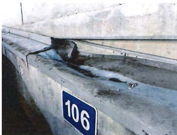
39 - flashing damage.JPG
