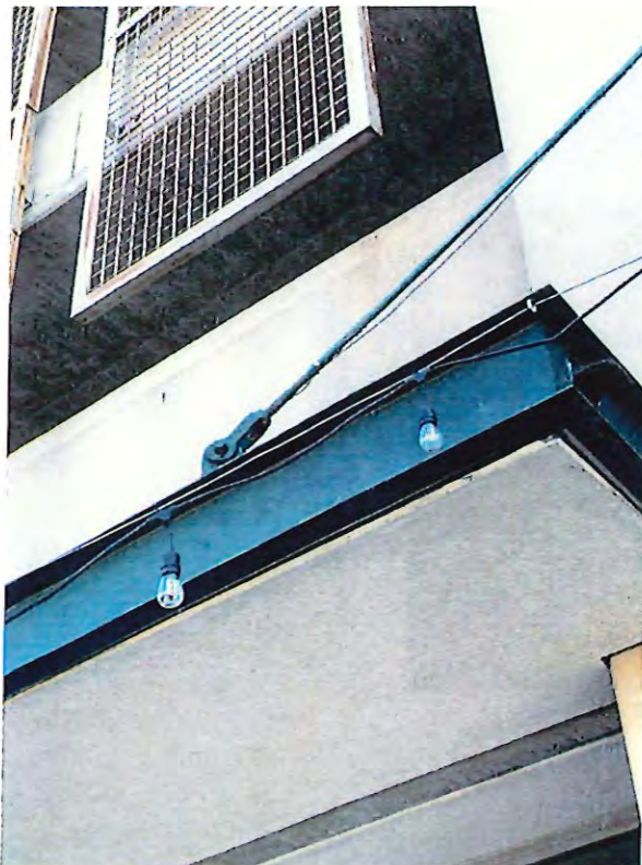
35 - awning hangar corrosion.JPG
