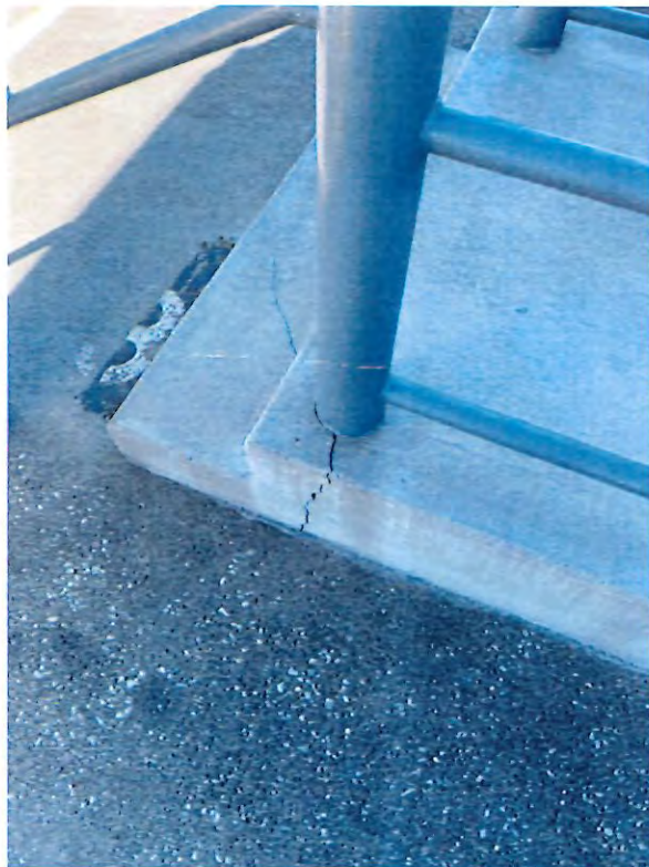
15 - spalled concrete step.JPG
