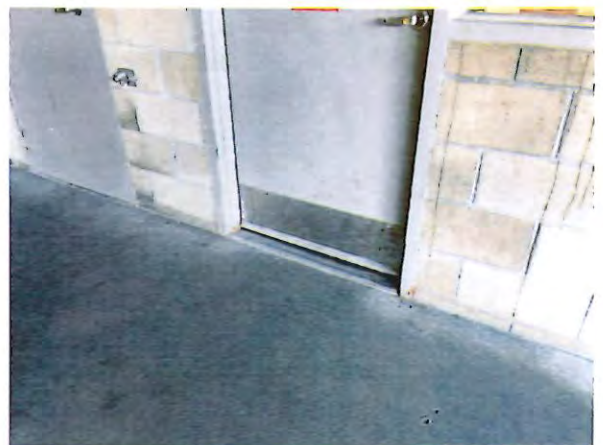
32 - door frame corrosion.JPG
