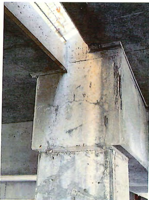
3 - column cracks.JPG
