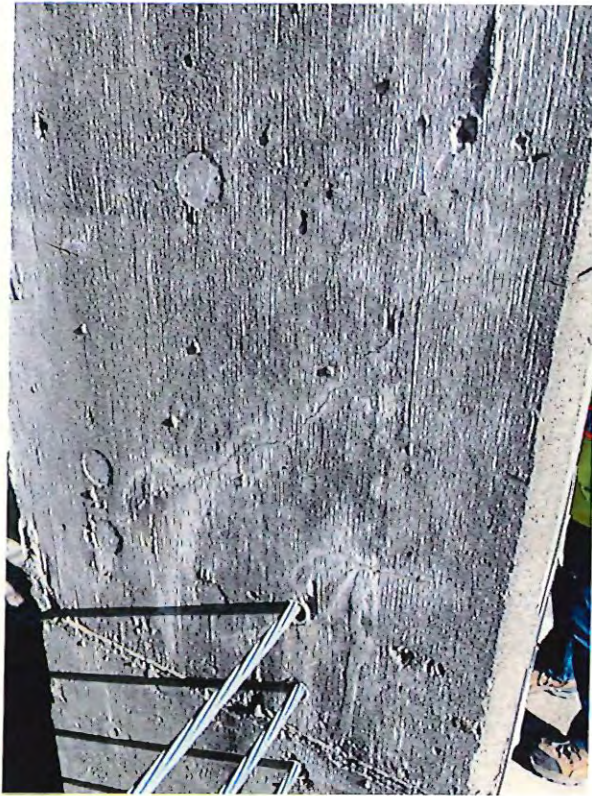
1 - column cracks.JPG
