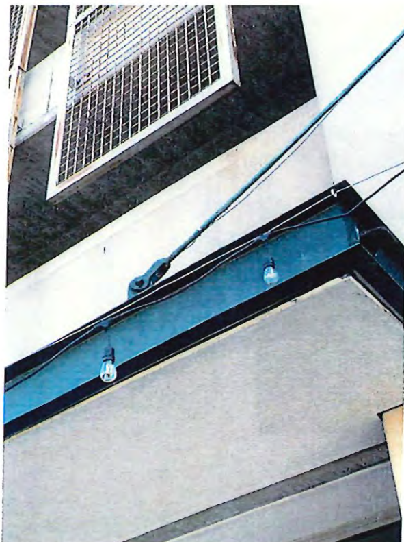
35 - awning hangar corrosion.JPG
