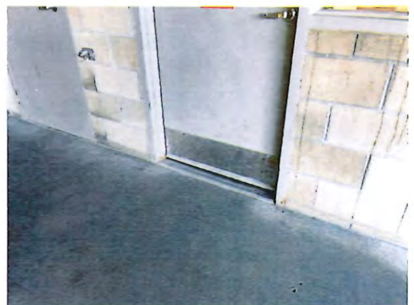
32 - door frame corrosion.JPG
