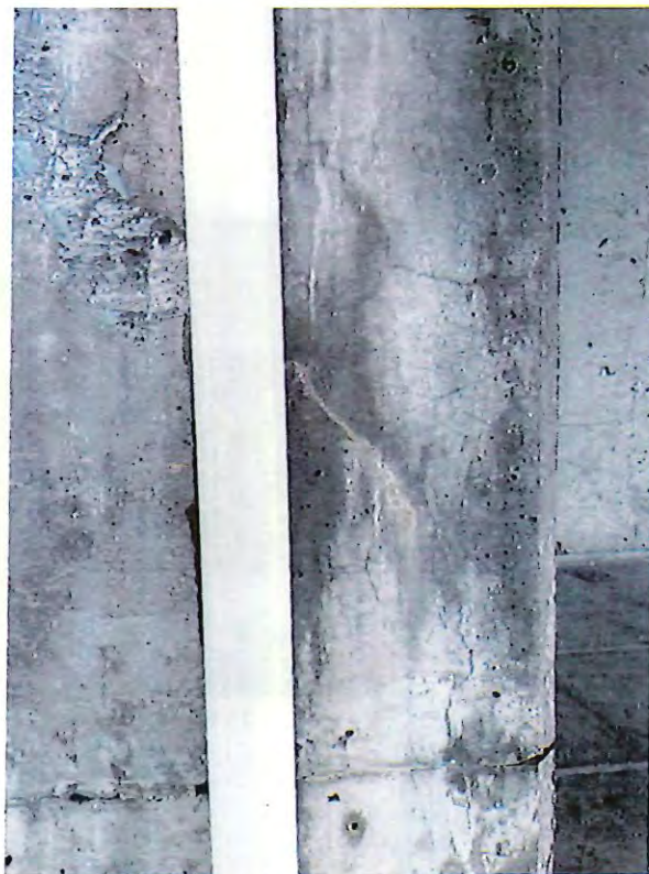
2 - column cracks.JPG
