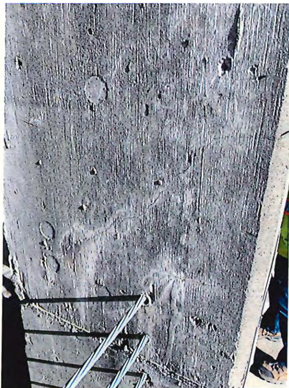
1 - column cracks.JPG
