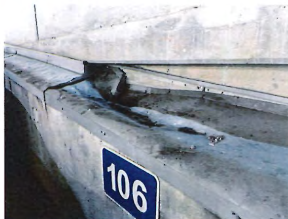
39 - flashing damage.JPG
