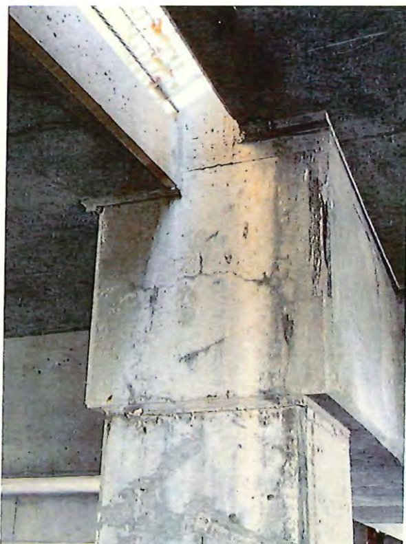
3 - column cracks.JPG
