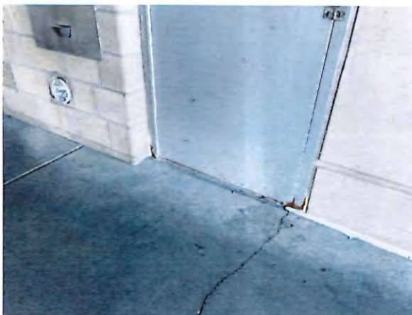
31 - door frame corrosion.JPG
