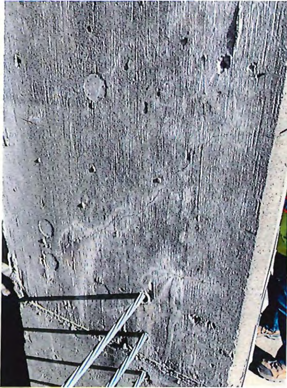
1 - column cracks.JPG
