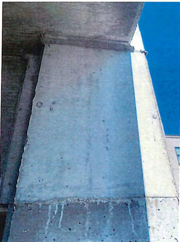
3 - column cracks.JPG
