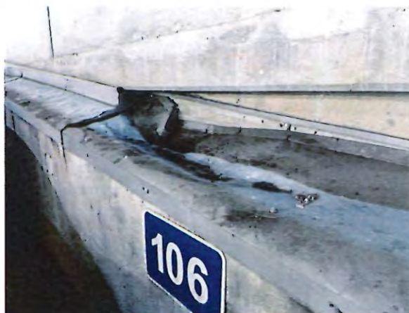
39 - flashing damage.JPG
