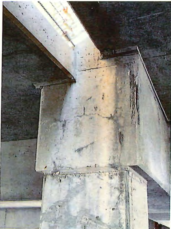
3 - column cracks.JPG
