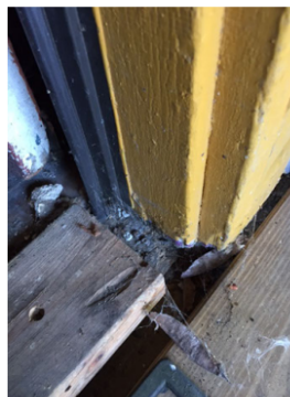
rotting door jam.jpeg
