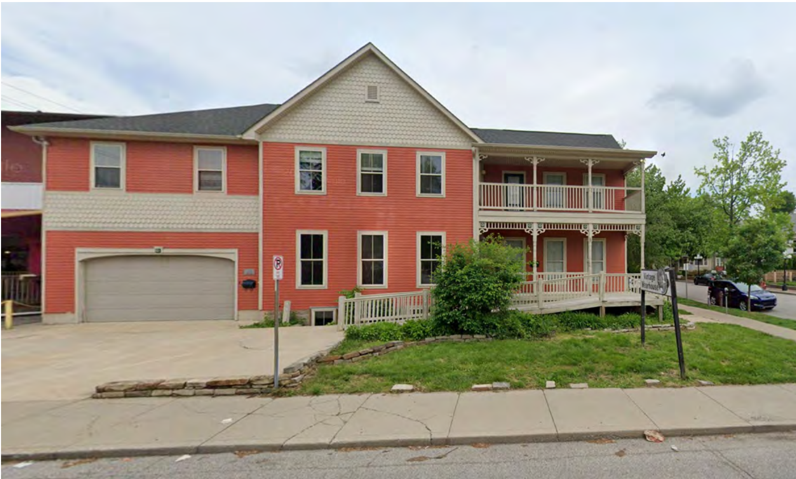
West Elevation (S. Grant Street)
