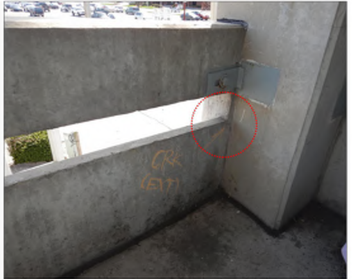
REPAIR ID - 07E
