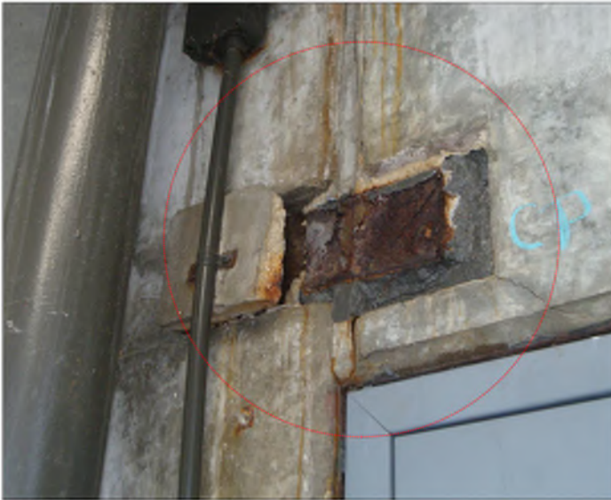
REPAIR ID - 05E
